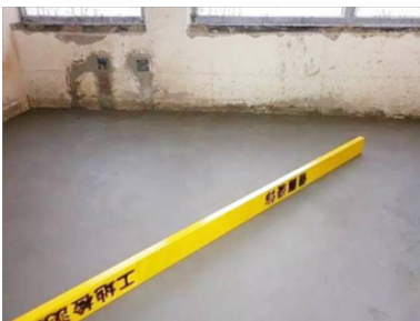
图 1.3.1-2 水泥砂浆地面实景
