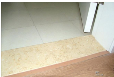
图 1.2.3-3 斜面过渡处理实景
